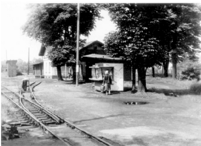
Zastávka tramvaje Hedvika.
