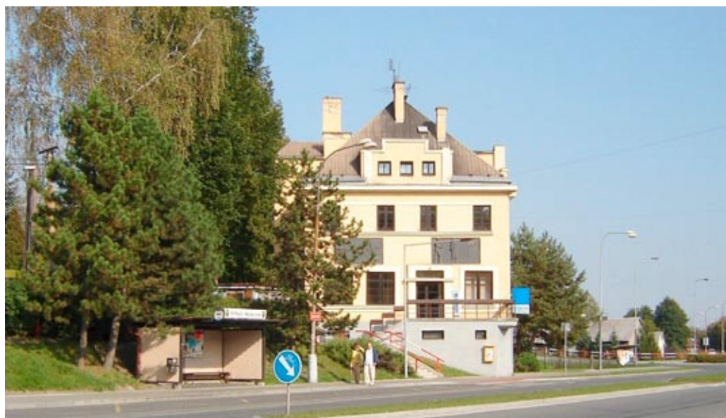
Česká spořitelna z roku 1930. Ulice Ostravská v Petřvaldě. Foto Otakar Kochan 2007
