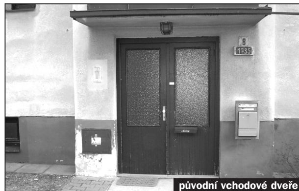
původní vchodové dveře
