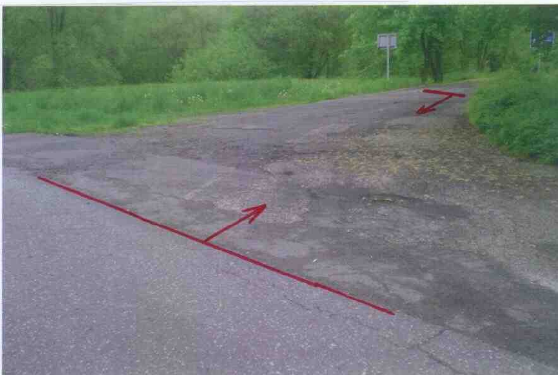
b) ul. Dolní – křižovatka ul. Dolní s ul. Šachetní
