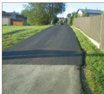
ul. Nad Doly po opravě
