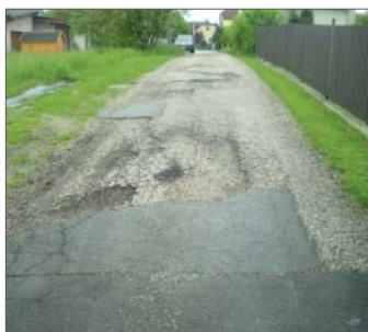
ul. Nad Doly před opravou
