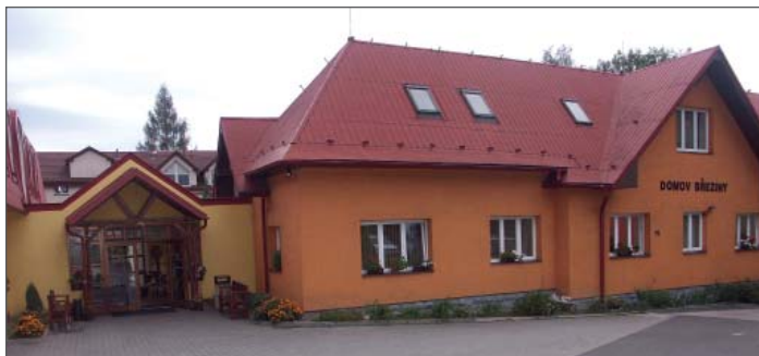
Domov Březiny - vchod k recepci a správní budova
