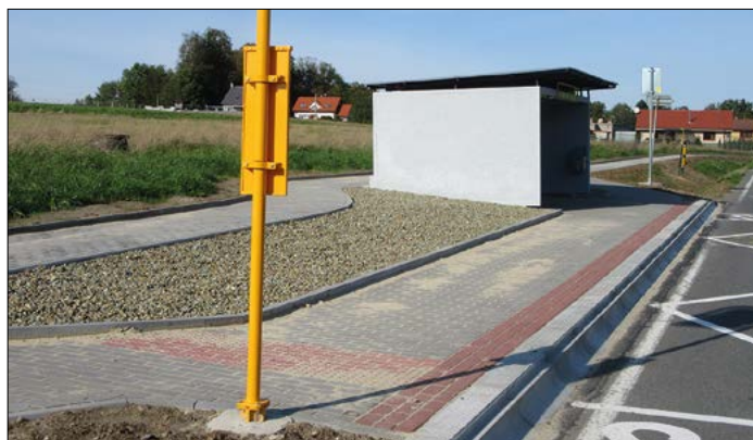
Opravené byly některé chodníky
