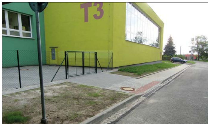
Na školní tělocvičně proběhla výměna oken
