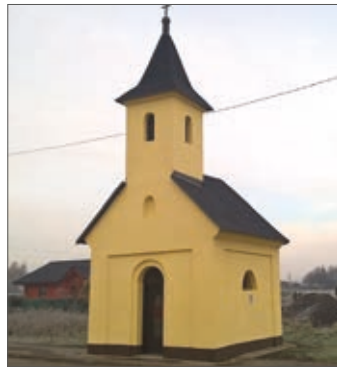
Oprava kapličky na ul. Závodní
