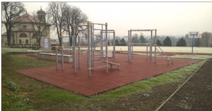
Stavba streetworkoutového hřiště na ZŠ Školní
