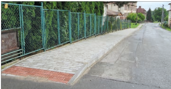
Provedení rekonstrukce chodníku na ul. Závodní u č. p. 561
