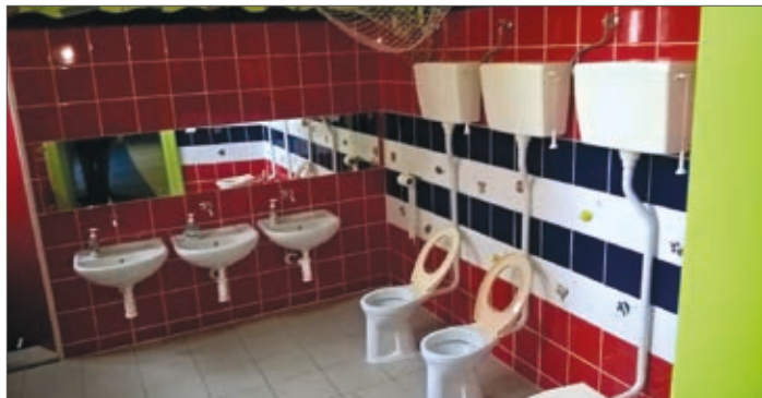
Rekonstrukce umývárny a WC pro děti na MŠ Závodní
