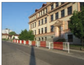
Nové zábradlí na ul. Závodní
