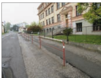
Původní zábradlí na ul. Závodní
